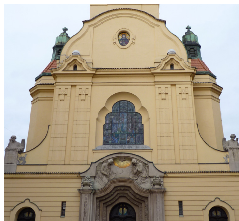
Obr. 22 Brno, kostel Neposkvrněného početí Panny Marie, detail střední části průčelí, 1910–1913. Foto: Vladislava Říhová
