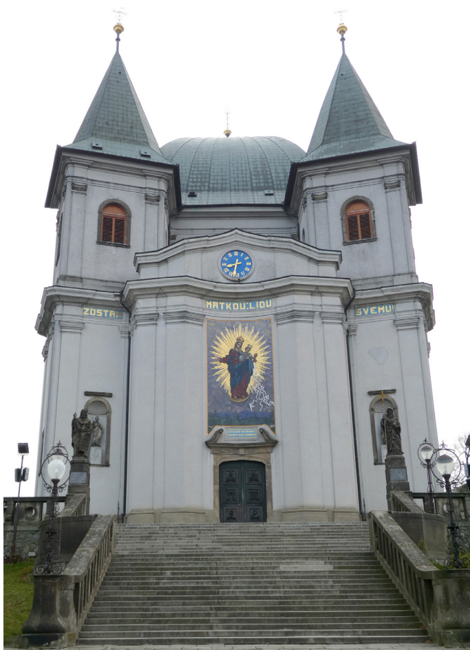
Obr. 2 Hostýn, bazilika Nanebevzetí Panny Marie, celek vstupní fasády s mozaikovým dekorem, 1912. Foto: autorka
