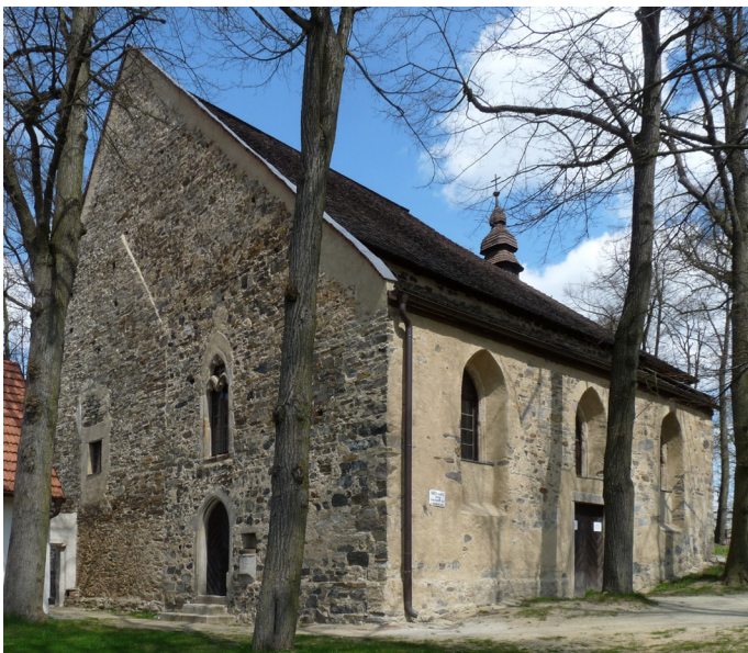
Obr. 8 Západní průčelí kostela, pohled z jihozápadu, 2009. Foto: autorka
