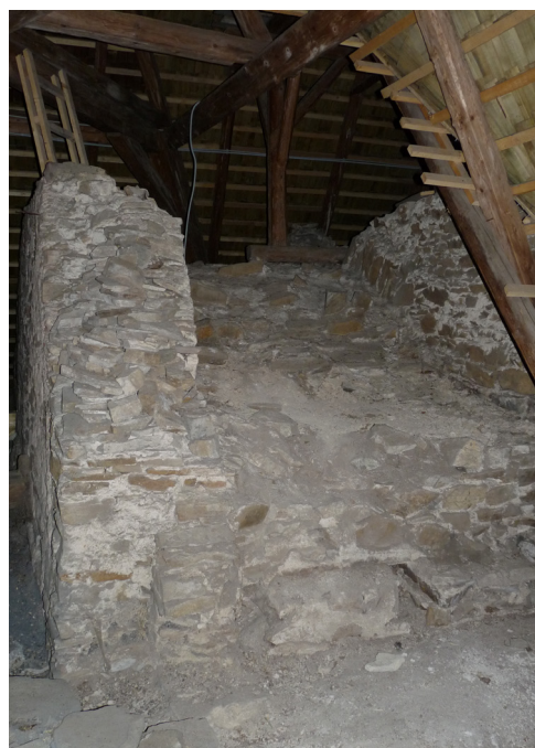
Obr. 27 Fragment konstrukce štítu nad vítězným obloukem, pohled z jihu, 2010. Foto: autorka
