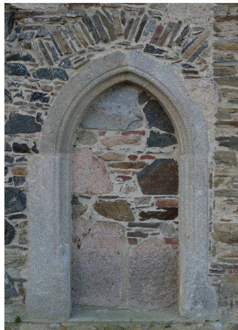
Obr. 15 Severní průčelí presbytáře, vstupní portál, 2009.
