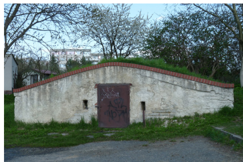
Obr. 29 Horní haltýř jemnického vodovodu, 2009.
