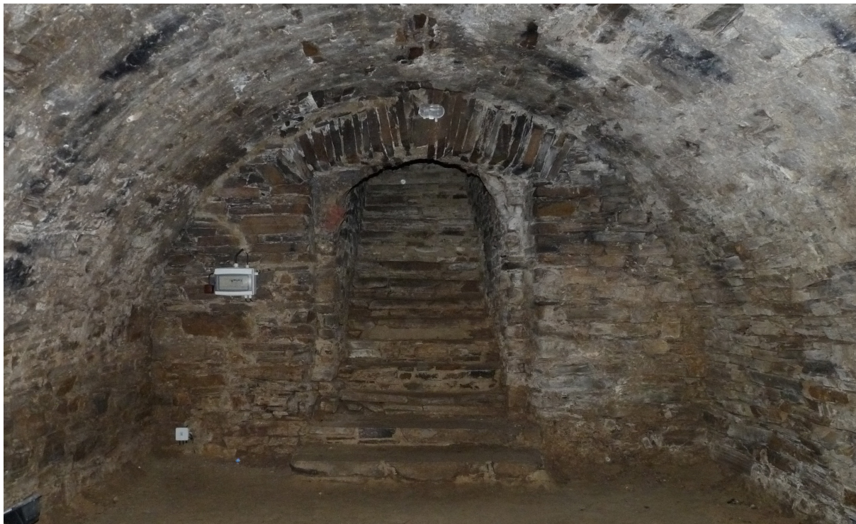
Obr. 28 Hlavní sklepní prostor při kostele, pohled z jihu, 2009. Foto: autorka
