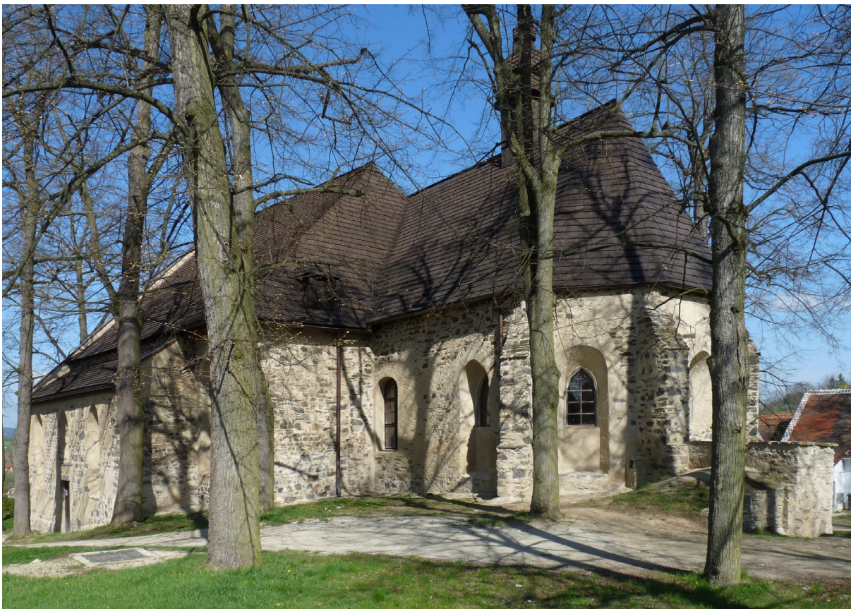
Obr. 7 Východní průčelí kostela, pohled z jihovýchodu, 2009. Foto: autorka
