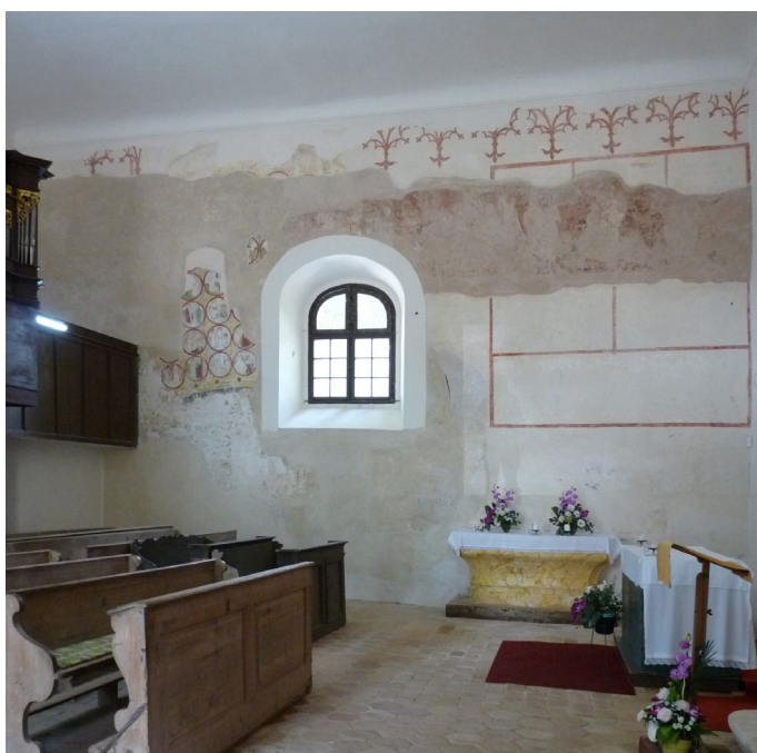
Obr. 20 Severní stěna lodi, pohled z jihu, 2012. Foto: autorka
